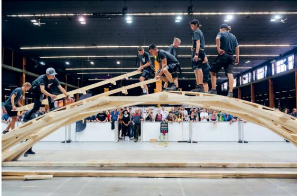
Zimmerleute arbeiten Hand in Hand, hier bauen sie gemeinsam eine Da-Vinci-Brücke. Die Kameradschaft wird auch mit dem Zimmermanns-Klatsch gelebt.
