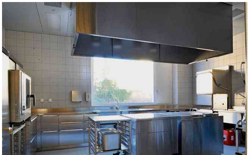
In das Kirchgemeindehaus wurde neu auch eine semiprofessionelle Küche zur Verpflegung der Benutzer eingebaut.
