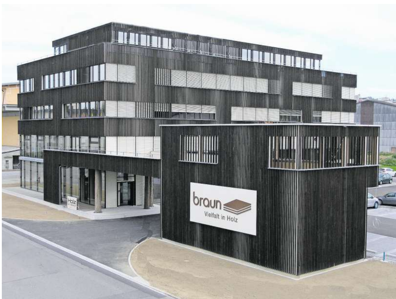
Die Aussenfassade ist eine Kombination aus horizontalen Fensterbändern und vertikal montierten Tannenholzlaten. Bilder: PD
