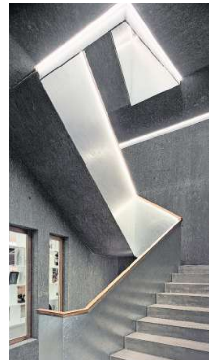
Feuerverzinkte Oberflächen bei den Treppengeländern kontrastieren zum Holz.
