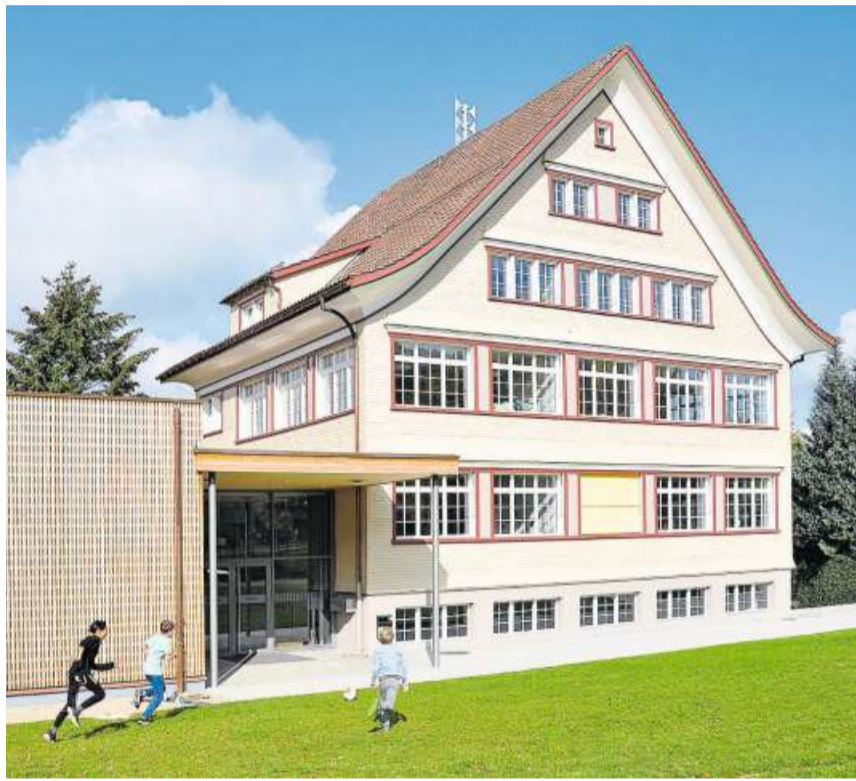
Bei der Renovierung wurde der Charme des alten Gebäudes bewahrt.
