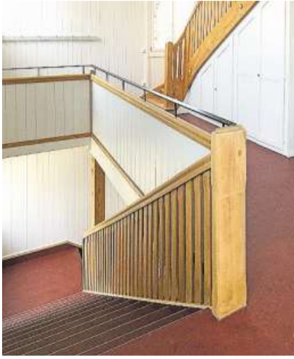
Blick ins schöne Treppenhaus.
